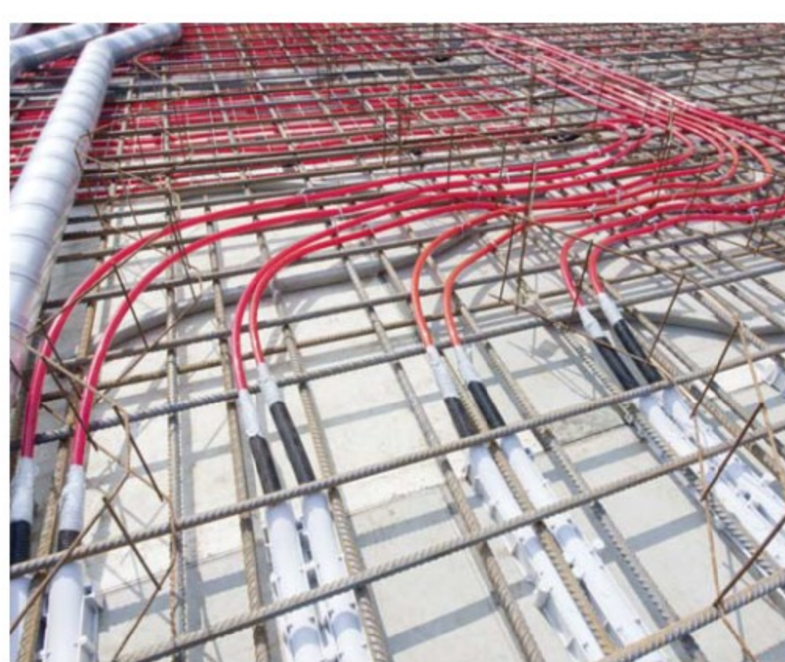
Anbindeleitung in den Schalungskasten geführt und abgedichtet
